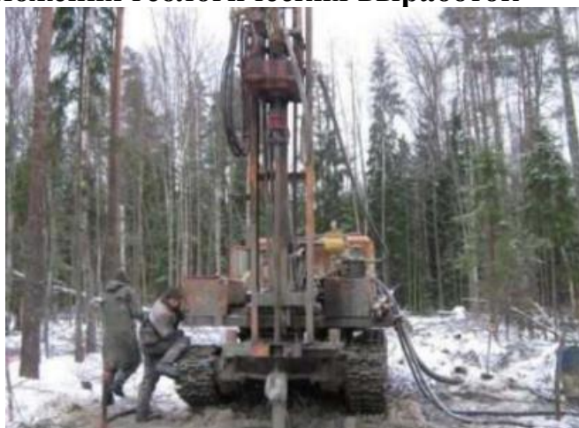
Рис.1. Бурение скважины
