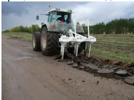
Рис. 5. Кирковщики на автогрейдере
