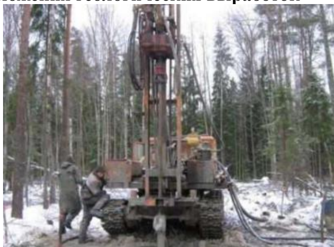
Рис.1. Бурение скважины
