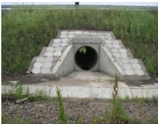
Рис.13 . Укрепление выходного русла комбинированного типа:
